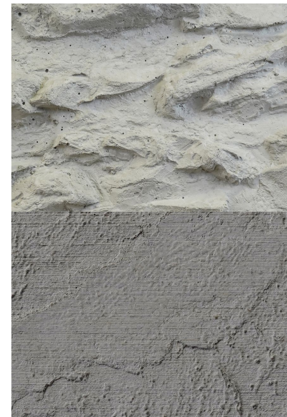
BETONoberfläche Durch verschiedene Matrzenschalungen individuell nach Wunsch
